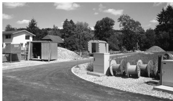
Im Baugebiet Rüegsauschachen herrscht rege Bautätigkeit
