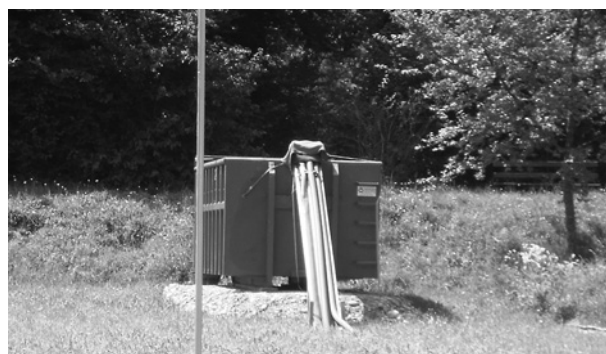
Becken für Grundwasserabsenkung
