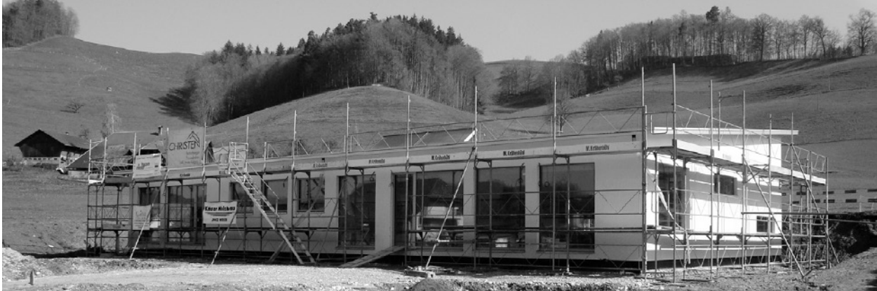
Neubau Kindergarten und Tagesstruktur Rain
