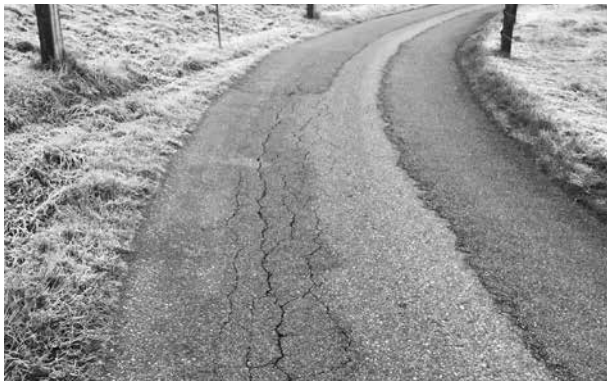
Hueb – Vor der Sanierung
