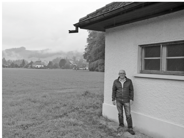
Andreas Meister vor dem Grundwasserpumpwerk Farbschachen
