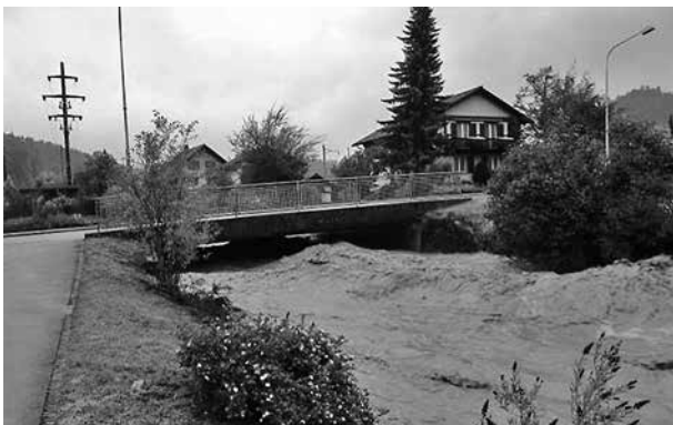
Strassenbrücke in Ramsei am 28.8.2005
