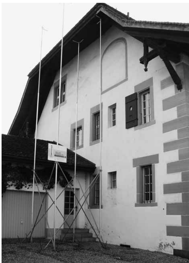
Auf der Nordseite entsteht ein Anbau mit Lift
