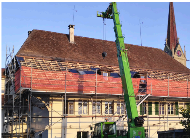
Bau der PV-Anlage Gemeindehaus 2021
