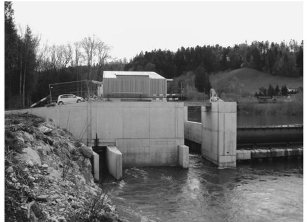
Durch den sogenannten Schlitzpass schwimmt der Fisch, das Turbinenhaus linksseitig umgehend, in das Oberwasser. Mit einem Schütz im Oberwasser kann der Fischaufstieg im Hochwasserfall abgeschottet werden. Eine Pumpe sorgt für eine minimale Wasserführung. Der neue Fischaufstieg ersetzt den alten, der jeweils bei Hochwasser verstopft wurde und nie richtig funktionierte.
