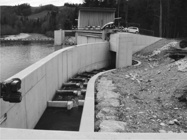
Das Hochwasser kann ungehindert abfliessen und spült den Stauraum der Anlage. Die linke Stauklappe ist nie ganz geschlossen. Das darüber strömende Wasser speist den Kolk unterhalb der Wehranlage und verhindert eine Austrocknung oder Überhitzung im Sommer.
