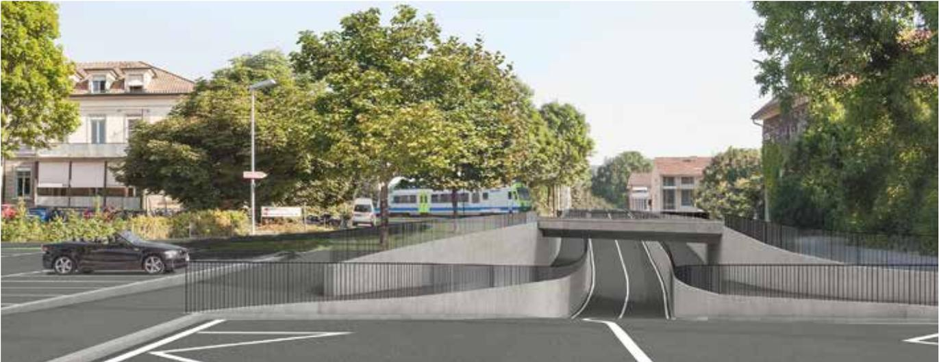
Bahnunterführung Spital: Die neue Unterführung ermöglicht ein niveaufreies Kreuzen von Bahn und Strasse und eliminiert damit die bisherigen Wartezeiten bei geschlossenen Barrieren.
