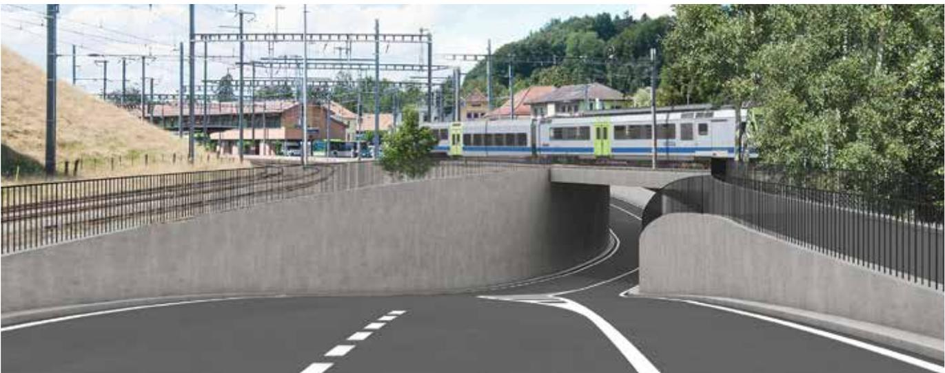
Unterführung Hasle b. B.: Auch in Hasle b. B. wird der Bahnübergang, der in den Verkehrsspitzenzeiten zu Rückstaus führt, durch eine Unterführung ersetzt.
