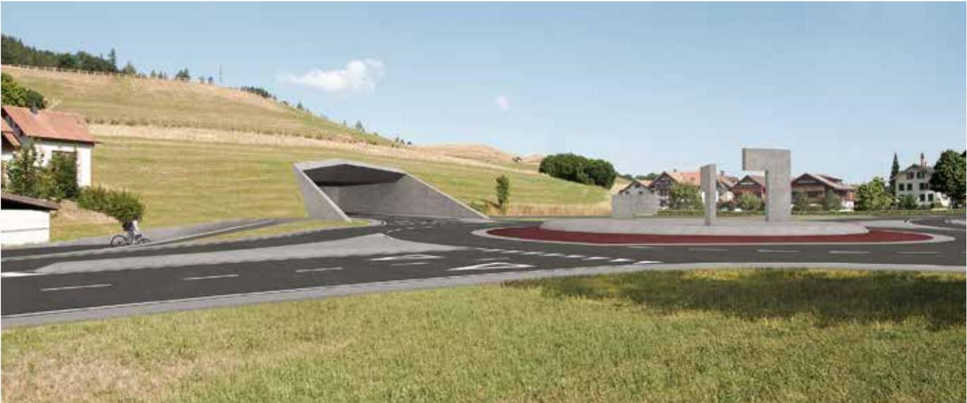
Knoten Oberburg Nord mit Südportal des Pleertunnels: Um den starken Linksabbiegeströmen gerecht zu werden, wird dieser Knoten als vierarmiger Turbokreisverkehr mit zweispurigen Zufahrten ausgebildet. Der Langsamverkehr wird abseits des Turbokreisverkehrs eigenständig geführt.
