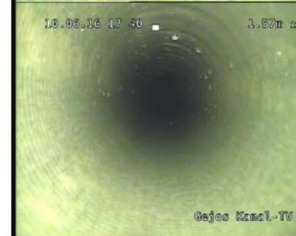
Die Leitung wurde mittels Inliner renoviert. Eine Dichtheitsprüfung wurde durch die Fa. KFS durchgeführt und bestanden.
