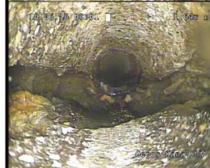
6 Jahre später vor der Sanierung mittels Inliner fehlen Rohrwandungen und die Leitung ist zum Teil eingestürzt. Das Erdreich ist sichtbar. Die Leitung ist nicht mehr funktionstüchtig
