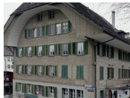
Gemeindehaus vor der Sanierung
