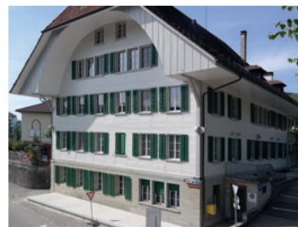
Gemeindehaus nach der Sanierung
