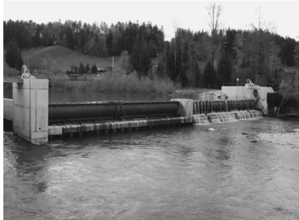
Das Hochwasser kann ungehindert abfließen und spült den Stauraum der Anlage. Die linke Stauklappe ist nie ganz geschlossen. Das darüber strömende Wasser speist den Kolk unterhalb der Wehranlage und verhindert eine Austrocknung oder Überhitzung im Sommer.
