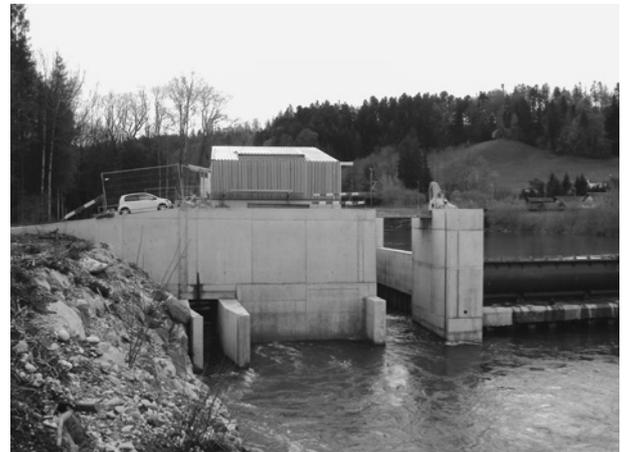
Durch den sogenannten Schlitzpass schwimmt der Fisch, das Turbinenhaus linksseitig umgehend, in das Oberwasser. Mit einem Schütz im Oberwasser kann der Fischaufstieg im Hochwasserfall abgeschottet werden. Eine Pumpe sorgt für eine minimale Wasserführung. Der neue Fischaufstieg ersetzt den alten, der jeweils bei Hochwasser verstopft wurde und nie richtig funktionierte.
