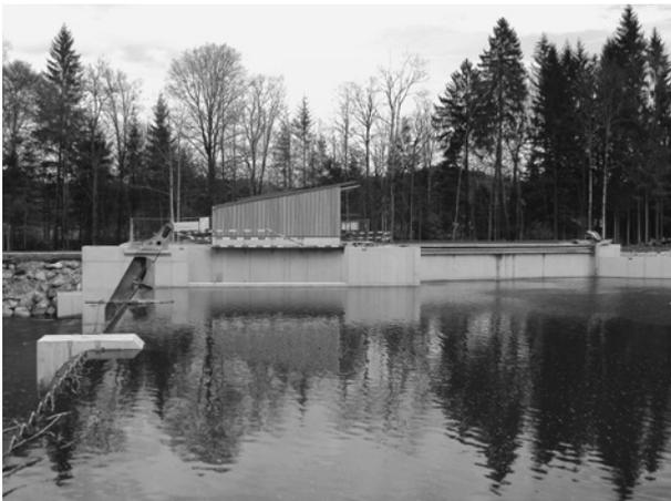
Das Wasser wird oberhalb der «Gohlhauschwelle» im Einlaufbauwerk der Emme entnommen und fliesst durch den Horizontalrechen der Turbine zu. Der Rechen selber ist nicht sichtbar. Er hat zum Schutz der Fische horizontale Rechenstäbe mit einem Abstand von 1 cm. Sichtbar ist nur die Rechenreinigungsmaschine. Mit dieser wird das Schwemmgut seitlich abgestreift, über den Spülschütz ins Unterwasser geleitet und bleibt somit in der Emme.
