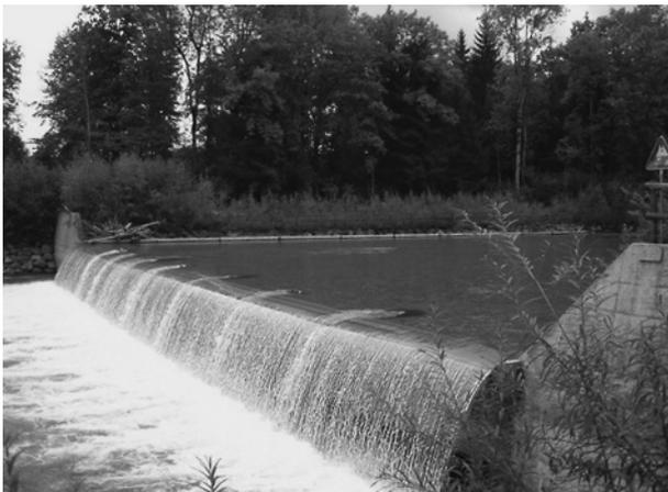
Die Ausbauwassermenge des Kleinwasserkraftwerks Gohlhaus beträgt  $16\text{m}^3/\text{s}$  bei einer Fallhöhe von ca. 3.5m. Mit einer Nennleistung von 425kW ist eine jährliche Produktion von rund 2.2GWh möglich. Dies entspricht dem Verbrauch von ca. 600 Haushalten.
